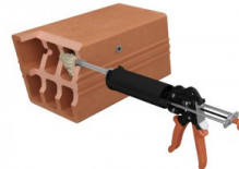
Inject the resin.
